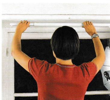
2. Reglați vergeaua la o înălțime de circa 15 cm peste ramă.
